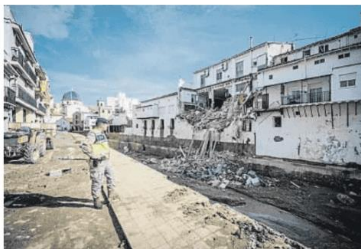
En Chiva, algunas casas cerca del barranco se derrumbaron
