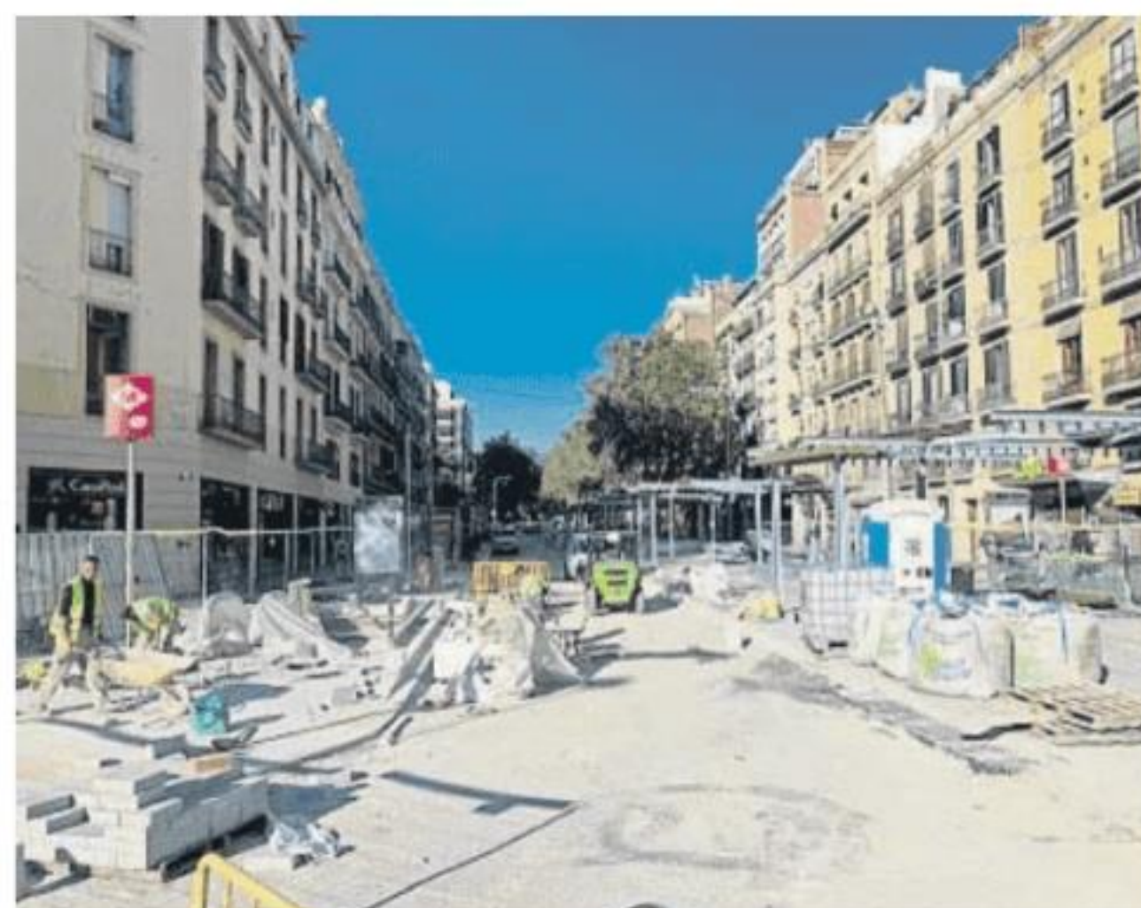
Las obras de esta ronda también continúan los domingos
